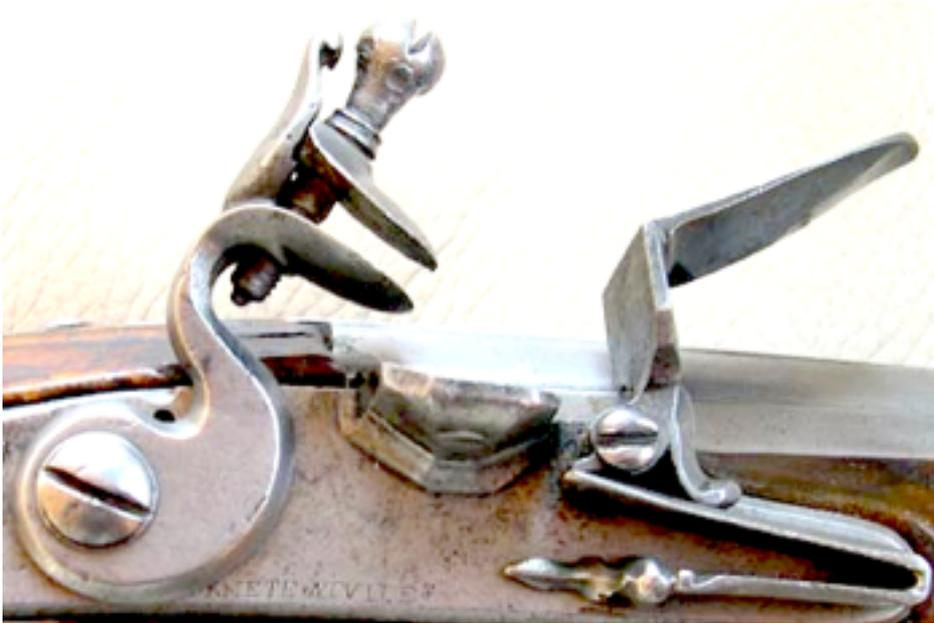
On voit bien sur cette platine d'un pistolet d'officier de cavalerie, daté de 1730 environ, qu'il n'y a pas de liaison mécanique entre la batterie et le bassinet.
